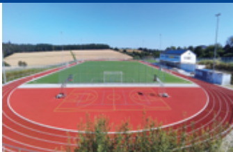
SG Hünstetten Sportanlage © Jens Prüller
